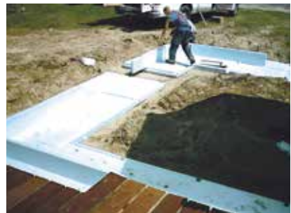
3. Placer les côtés de coffrage.
