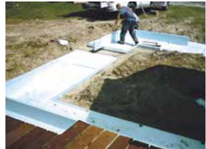
3. Placer les côtés de coffrage.
