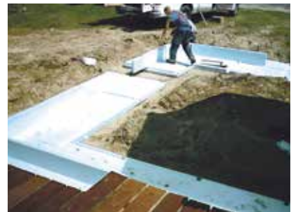
3. Placer les côtés de coffrage.
