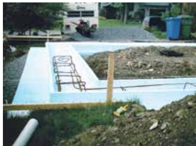
4. Déposer l'armature à l'intérieur de la semelle.
